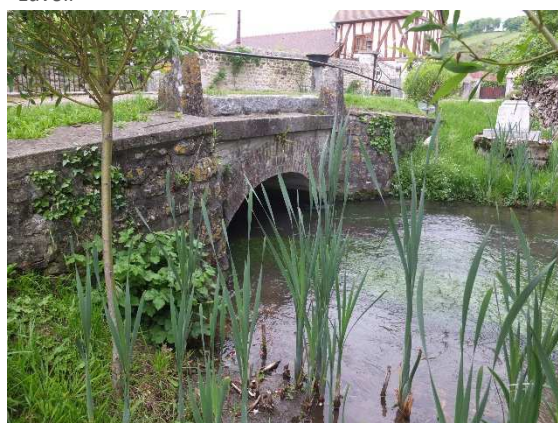
Pont de Chennevières
